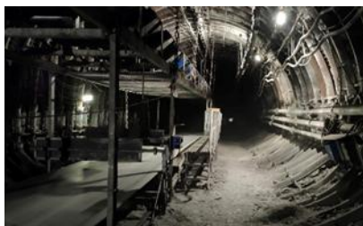
Rys. 3 Widok przenośnika taśmowego 1600 do transportu urobku i załogi
