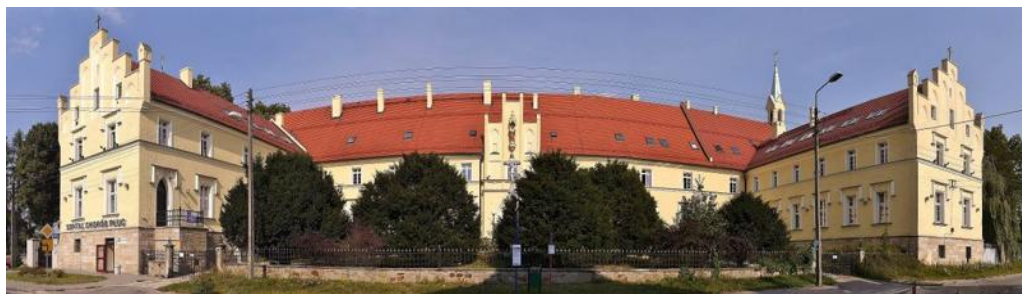
Rys. 7 Widok budynku szpitala w 2011 r. po wymianie pokrycia dachu
