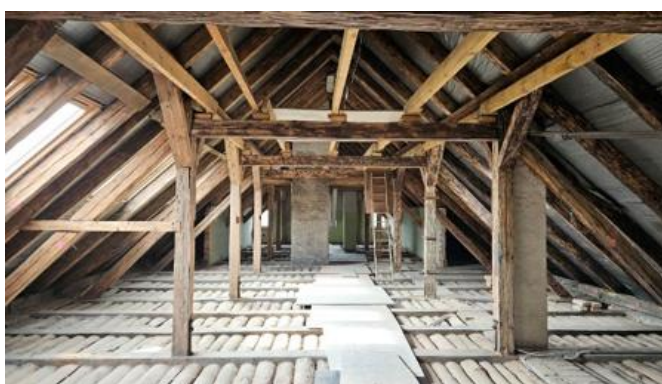
Rys. 9 Widok więźby skrzydła północno-zachodniego budynku
