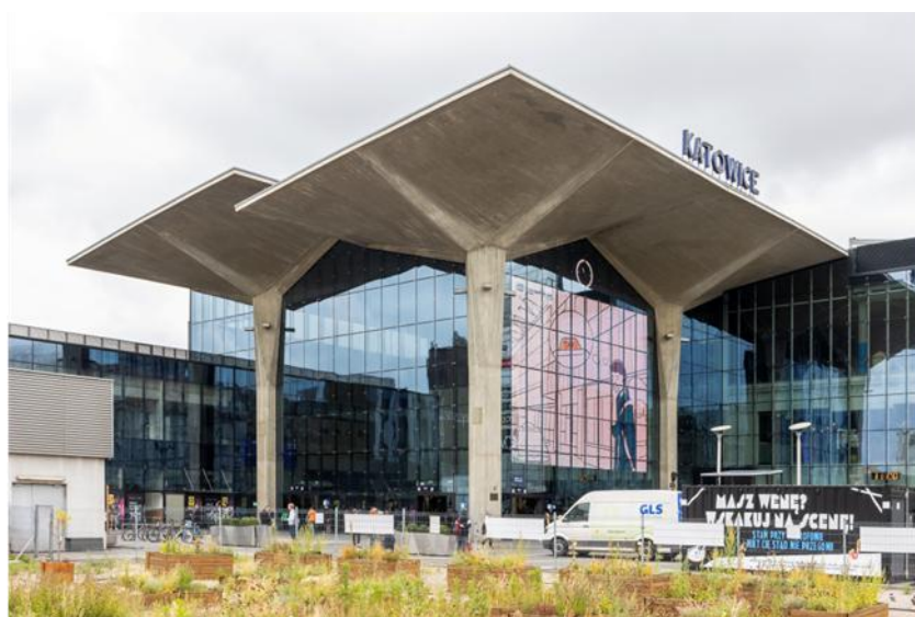
Rys. 3 Zrekonstruowane „kielichy” Dworca Kolejowego w Katowicach
