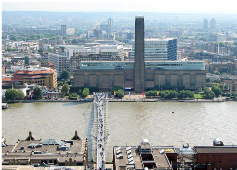
Rys. 1 Muzeum sztuki współczesnej Tate Modern w Londynie powstałe wskutek rewitalizacji Elektrowni Bankside Power Station
