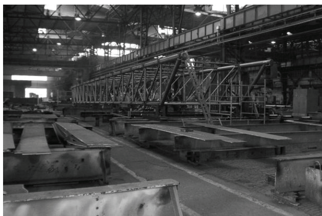
Rys. 1. Widok hali produkcyjnej
